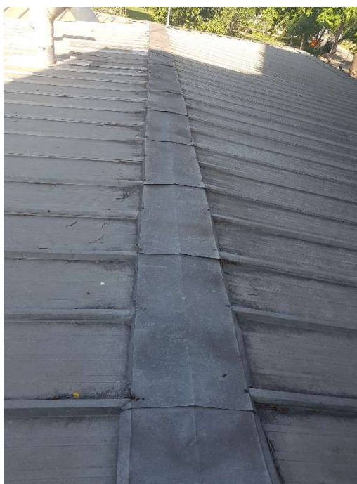
Figura 18 – Cumeeira amassada em virtude da passagem indevida pelos funcionários
