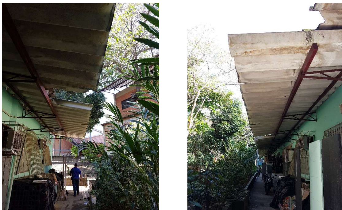
Figura 21 – Telhas danificadas em consequência do vão excessivo do balanço
