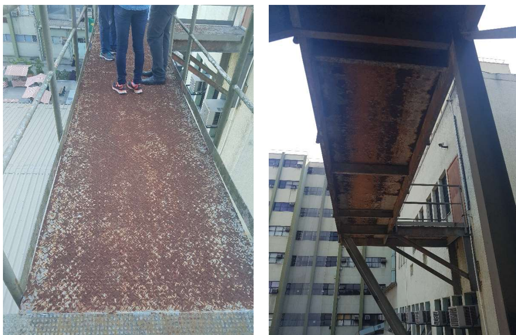
Figura 6 – Passarela com corrosão pelos mesmos motivos descritos na Figura 5 e frestas entre a ligação dos materiais (solda incompleta).
