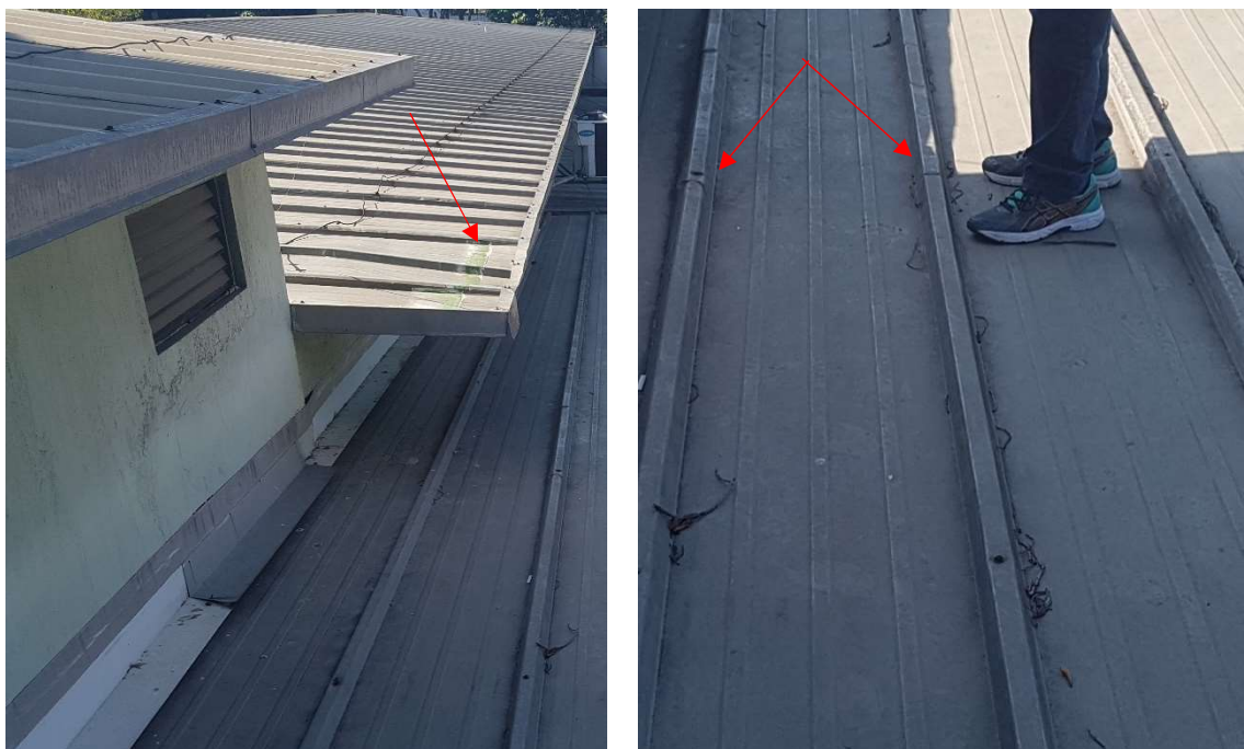
Figura 17 – Telhas amassadas por utilização inadequada e telhas rompidas devido a fragilização da terça.
