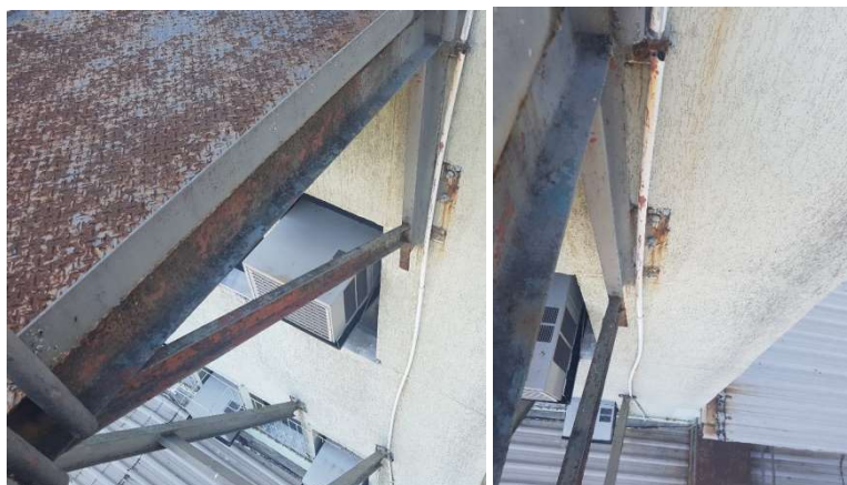
Figura 13 – Escoras (mão-francesa) e chumbadores com a pintura deteriorada e sinais de corrosão.
