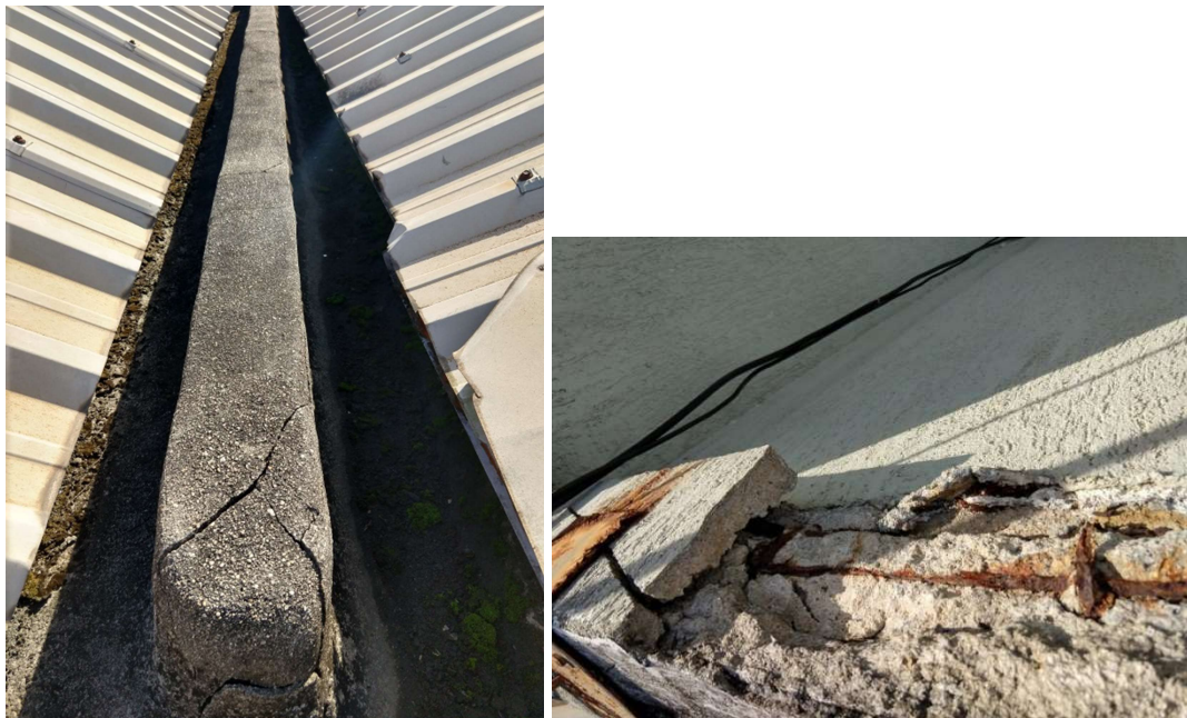
Figura 8 – Danos na argamassa de proteção mecânica da manta de impermeabilização e de alguns pontos da estrutura, permitindo, inclusive a exposição da armadura.
