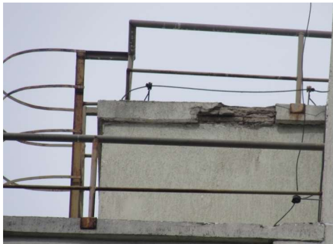
Figura 5 – Soltura do revestimento da platibanda, com exposição da armadura.
