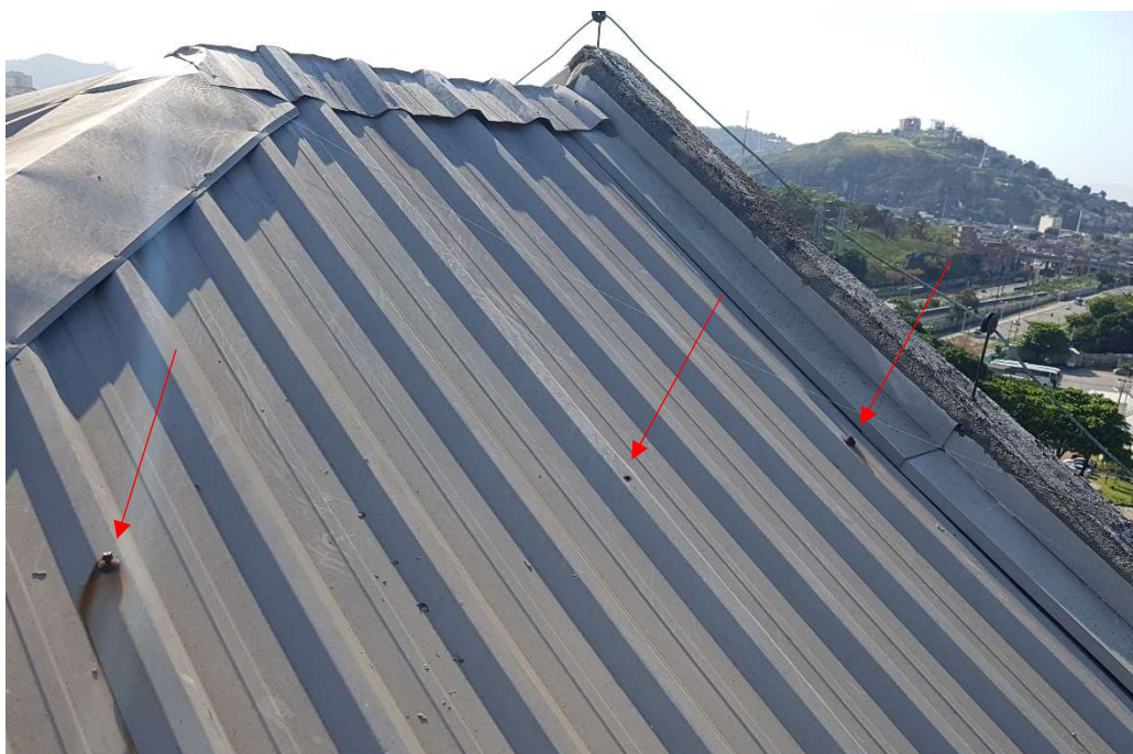
Figura 14 – Parafuso corroído, anel de vedação deteriorado e furo inutilizado na telha.
