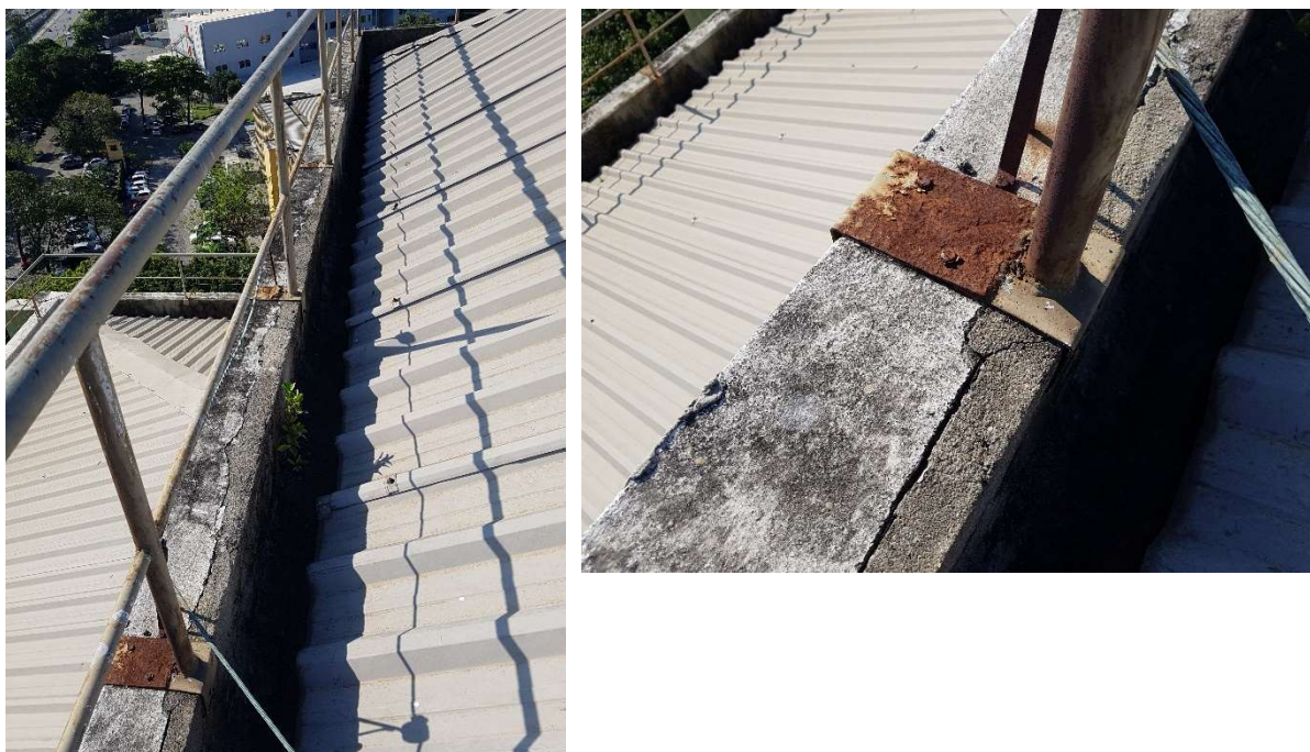
Figura 10 – Guarda corpo parcialmente corroído e base com emendas executadas de forma inadequada.
