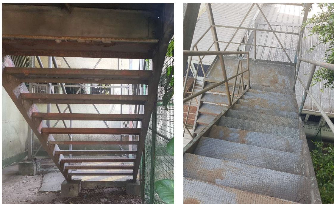
Figura 4 – Degraus em processo corrosivo antes da estrutura principal, devido à proteção mais branda e acúmulo de água em forma de poças.
