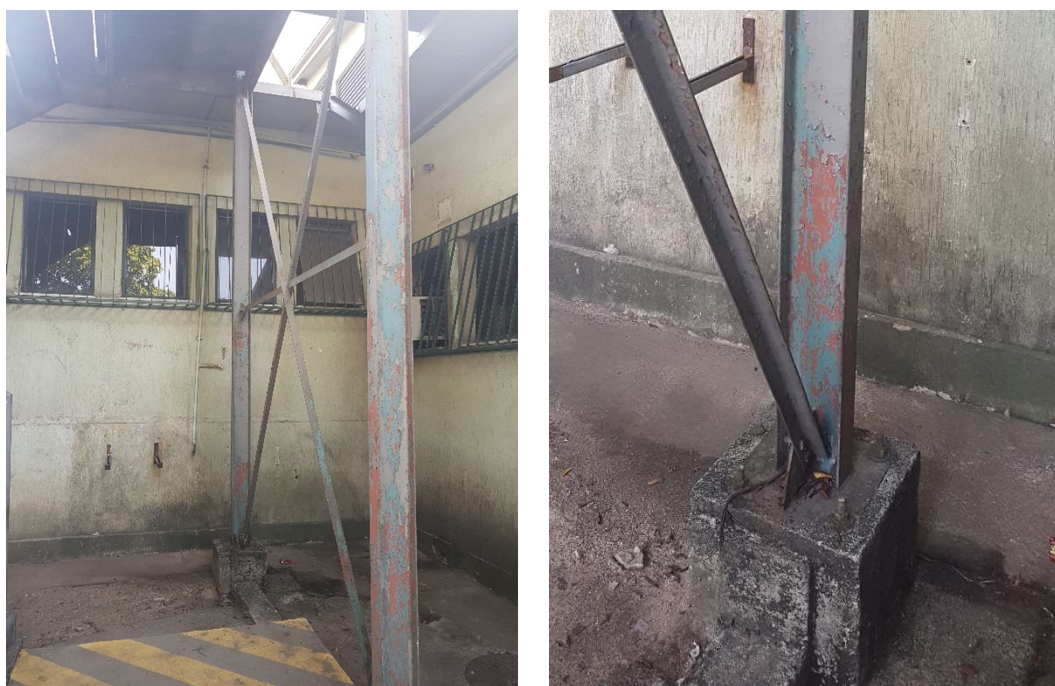
Figura 3 – A pintura se deteriora e expõe a estrutura ao processo de corrosão.
