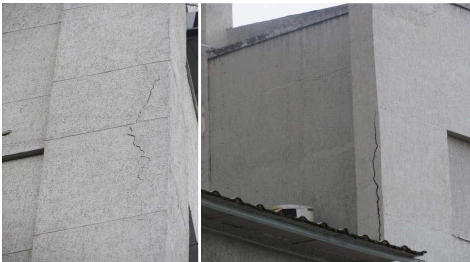
Figura 6 – Trincas do revestimento em canto de pilar e alvenaria.
