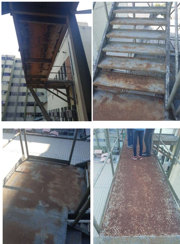
Figura 14 – Corrosão em pisos e patamares
