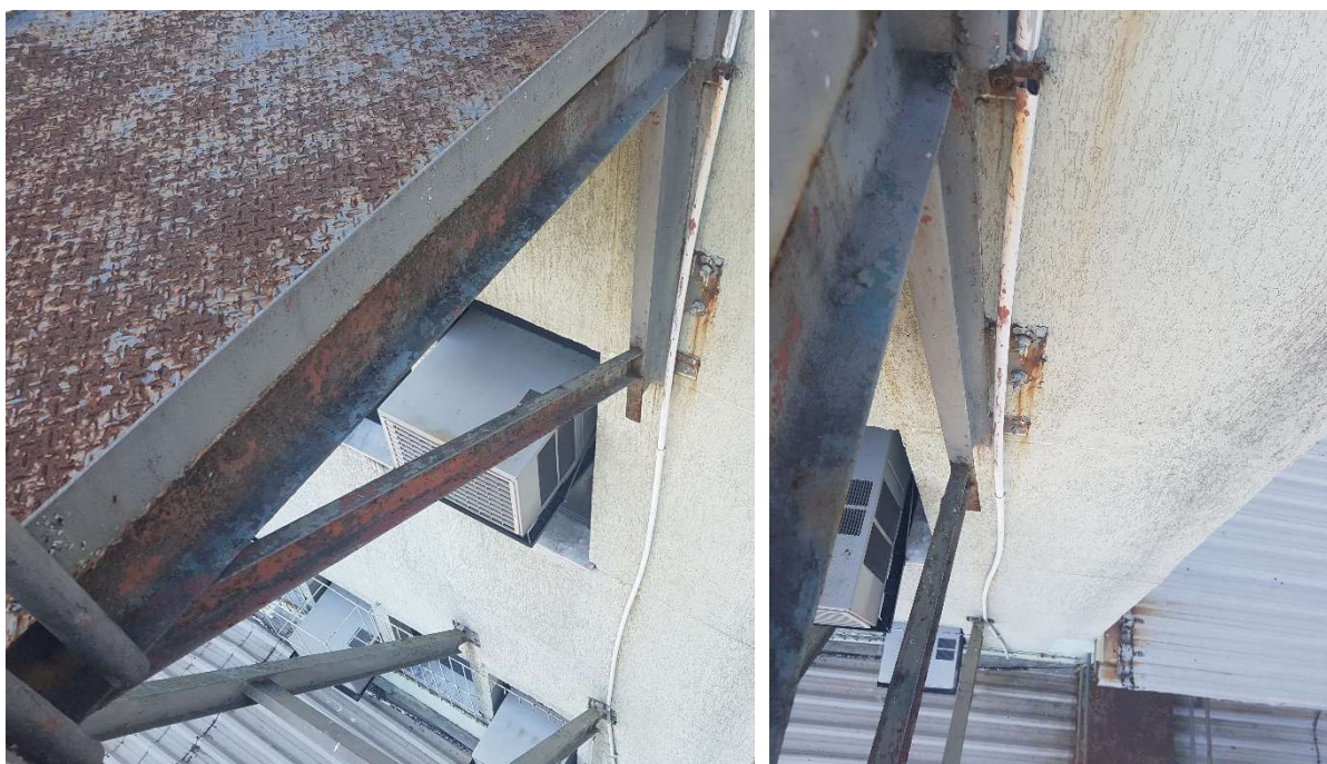
Figura 7 – Escoras (mão-francesa) com a pintura deteriorada e chumbadores com corrosão.
