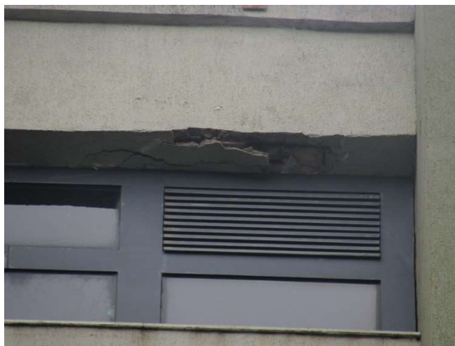
Figura 4 – Armadura exposta na parte superior do vão da esquadria.
